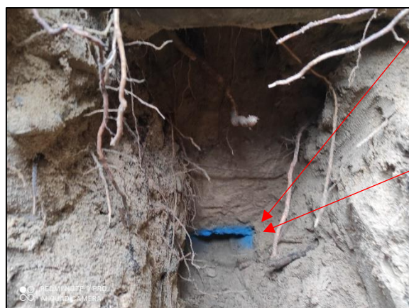
Base du massif béton vers 1,48 m de profondeur (cote de +2,96 m NGF), assis dans des sables beiges
